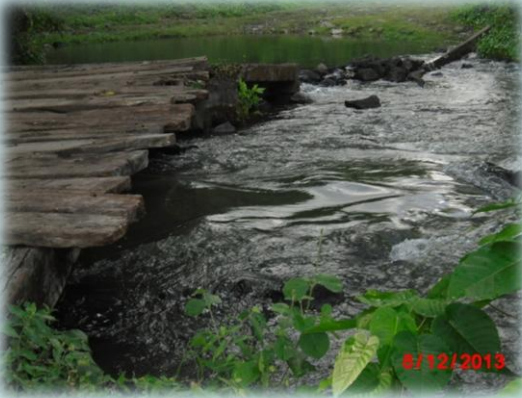
PUENTE QUE ATRAVIESA EL RIO MANARES
