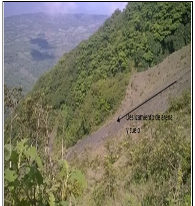
Foto N° 4: Pendiente donde se desplaza el suelo y arena. Coordenadas: 65000E, 127500N
