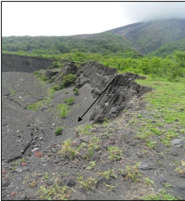
Foto N° 3: Desprendimiento de material suelto de la cárcava. Coordenadas: 649043E, 1274533N
