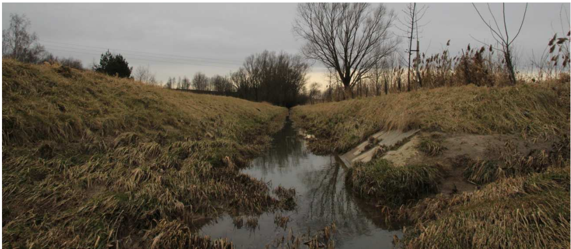
Obr. 35 Koryto Oldřiovského potoku upravené na kulminační průtok Q_{100} [foto: Jan Pastrňák]
