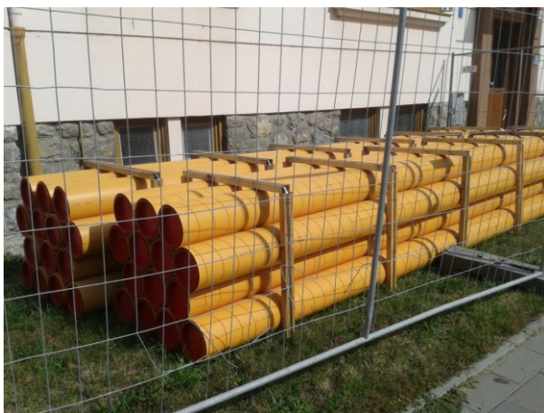
Obr. 16, 17: Skladování trubního materiálu dn 225 PE 100 SDR 17,6 s ochranným pláštěm z PP (označení DUALTEC) na stavbě a jeho svaření do sekcí (foto autor)
