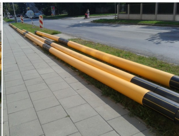
Obr. 16, 17: Skladování trubního materiálu dn 225 PE 100 SDR 17,6 s ochranným pláštěm z PP (označení DUALTEC) na stavbě a jeho svaření do sekcí (foto autor)
