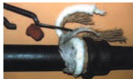
Obr. 1: Temovaný hrdlový spoj litinového potrubí [7]
