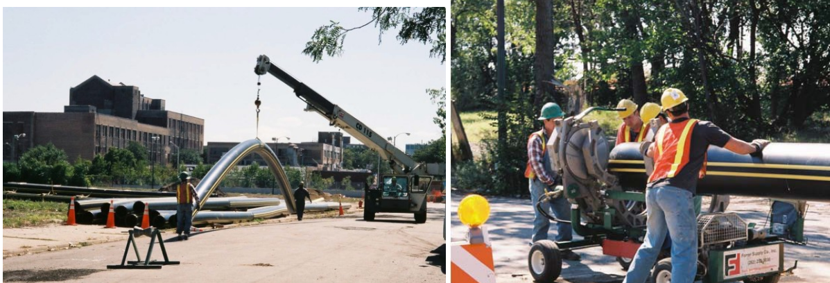
Obr. 19, 20: Montáž 18-palcového PE potrubí v Chicagu, IL [29]
