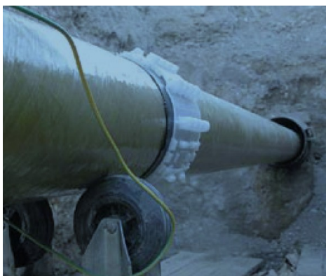
Obr. 7: Sklolaminátové potrubí STAR DN 200 PN 25 [12]
