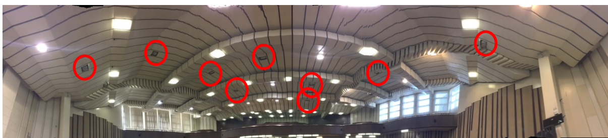
Obr. 42 Nefunkční svítidla - Aula SLU Karviná
