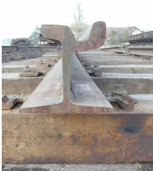
Obr.5 Tramvajová žlábková kolejnice [12]
