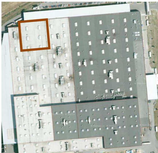
Obr. 7 Průmyslová hala, v které probíhala rekonstrukce
