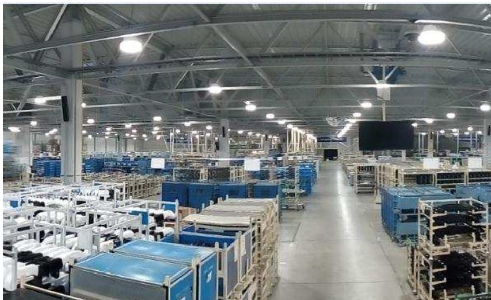
Obr. 15 Pohled na halu po výměně osvětlovacích systémů
