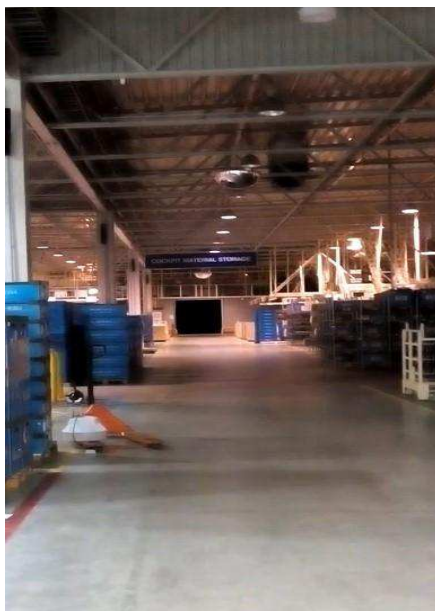
Obr. 11. V zadní části haly je vidět nedostatečné normativní světelně technické parametry.
