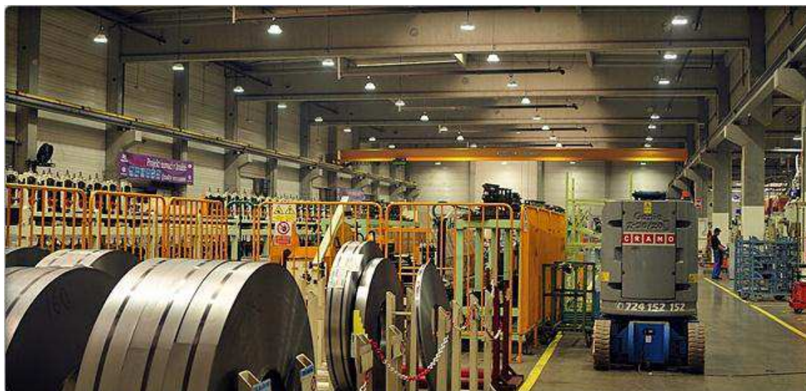
Obr. 4. Příklad celkového osvětlení prostoru [9]
