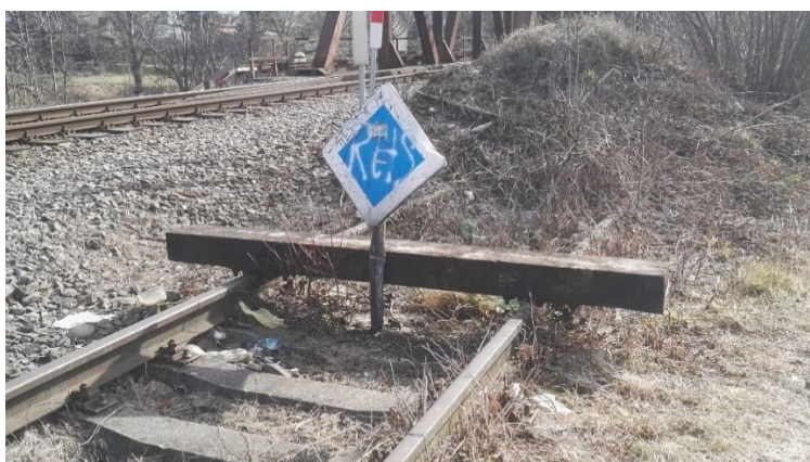
Obr. 11: Zarážedlo ukončující výtažnou kolej 4b (zdroj: autor)
