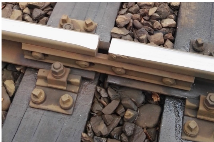
Obr. 15: Kolejnicový styk za mostní konstrukcí (zdroj: autor)
