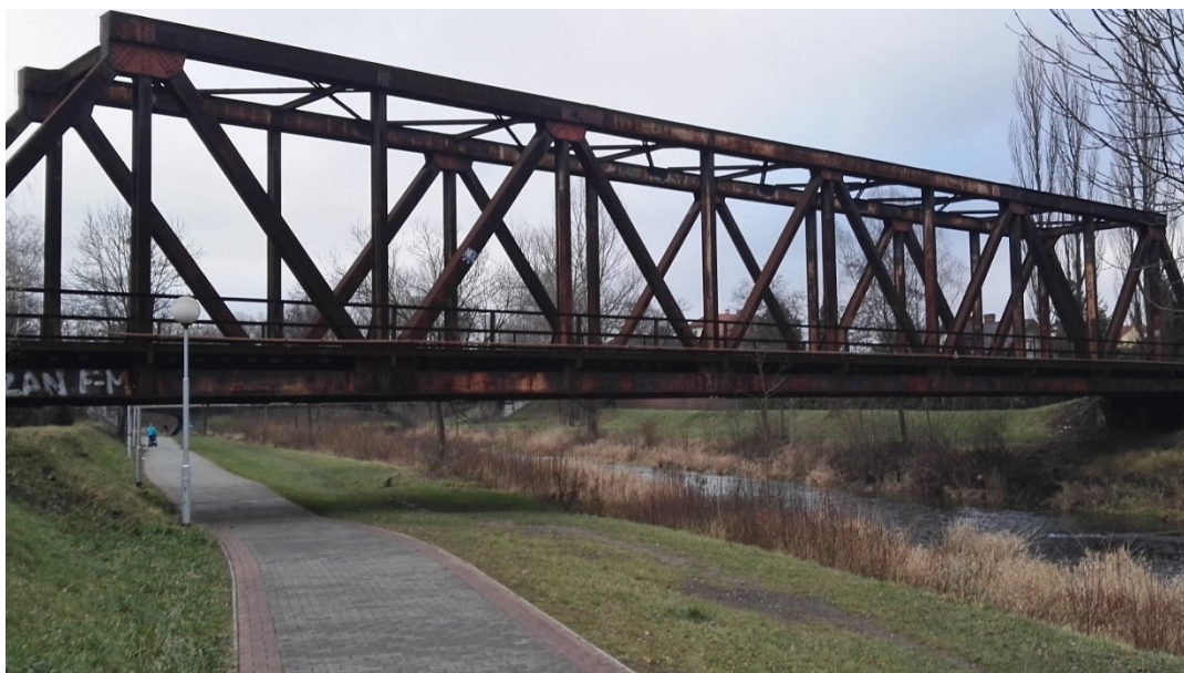
Obr. 14 Mostní konstrukce přes řeku Morávku v km 110,840 (zdroj: autor)
