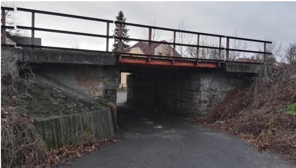
Obr. 13 Mostní konstrukce v km 110,998 (zdroj: autor)
