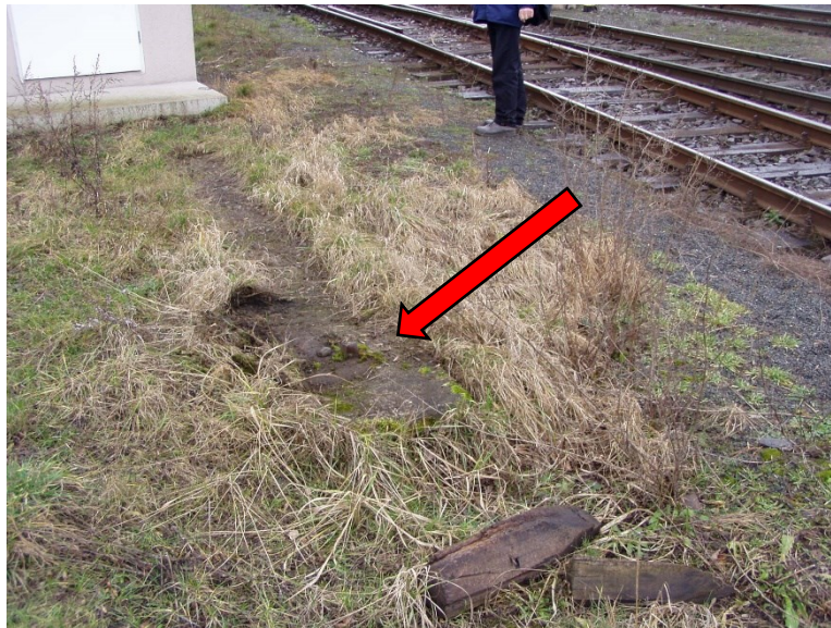
Obr. 16 Propustek v km 22,385 (zdroj: autor)
