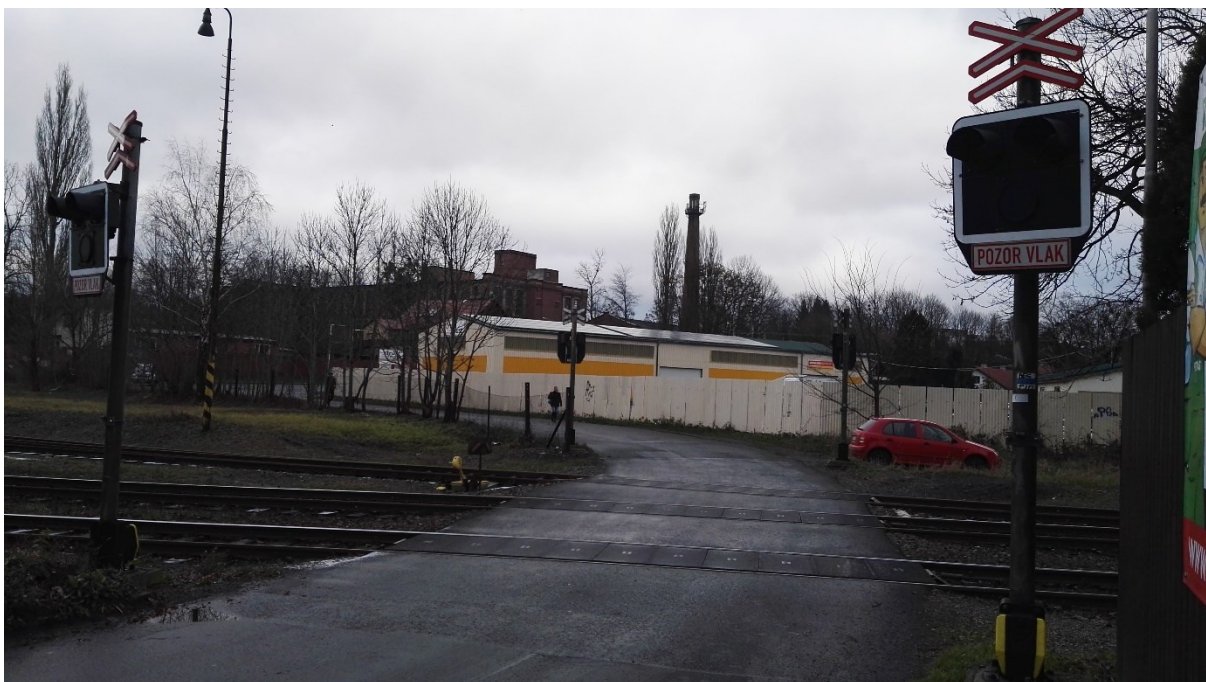
Obr. 17: Železniční přejezd v km 111,196 (zdroj: autor)
