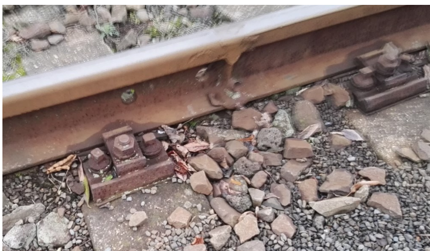
Obr. 10: Kolejový svařovaný styk (zdroj: autor)
