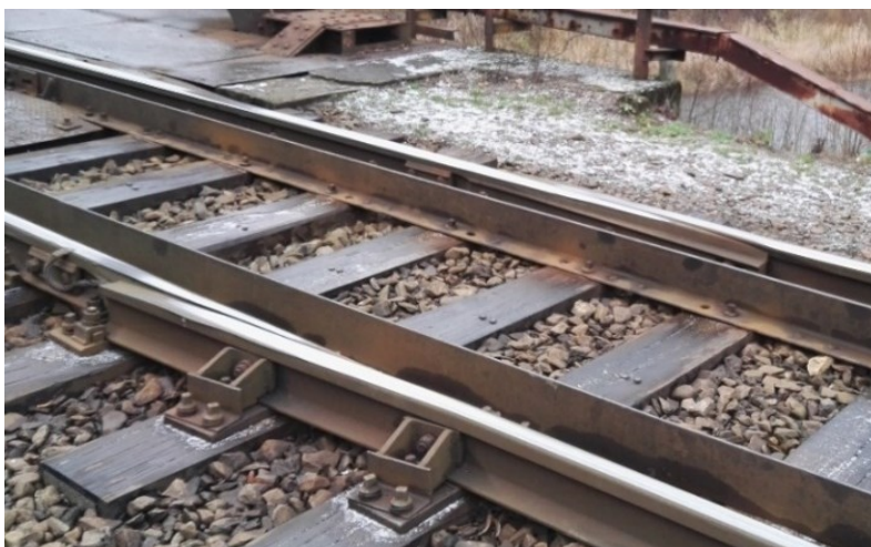
Obr. 19: Malé dilatační zařízení na stávající mostní konstrukci (zdroj: autor)
