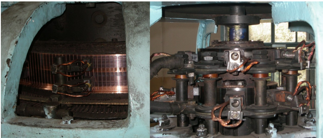
Obr. 2.6 Zobrazení (zleva) budiče a sběracího ústrojí
