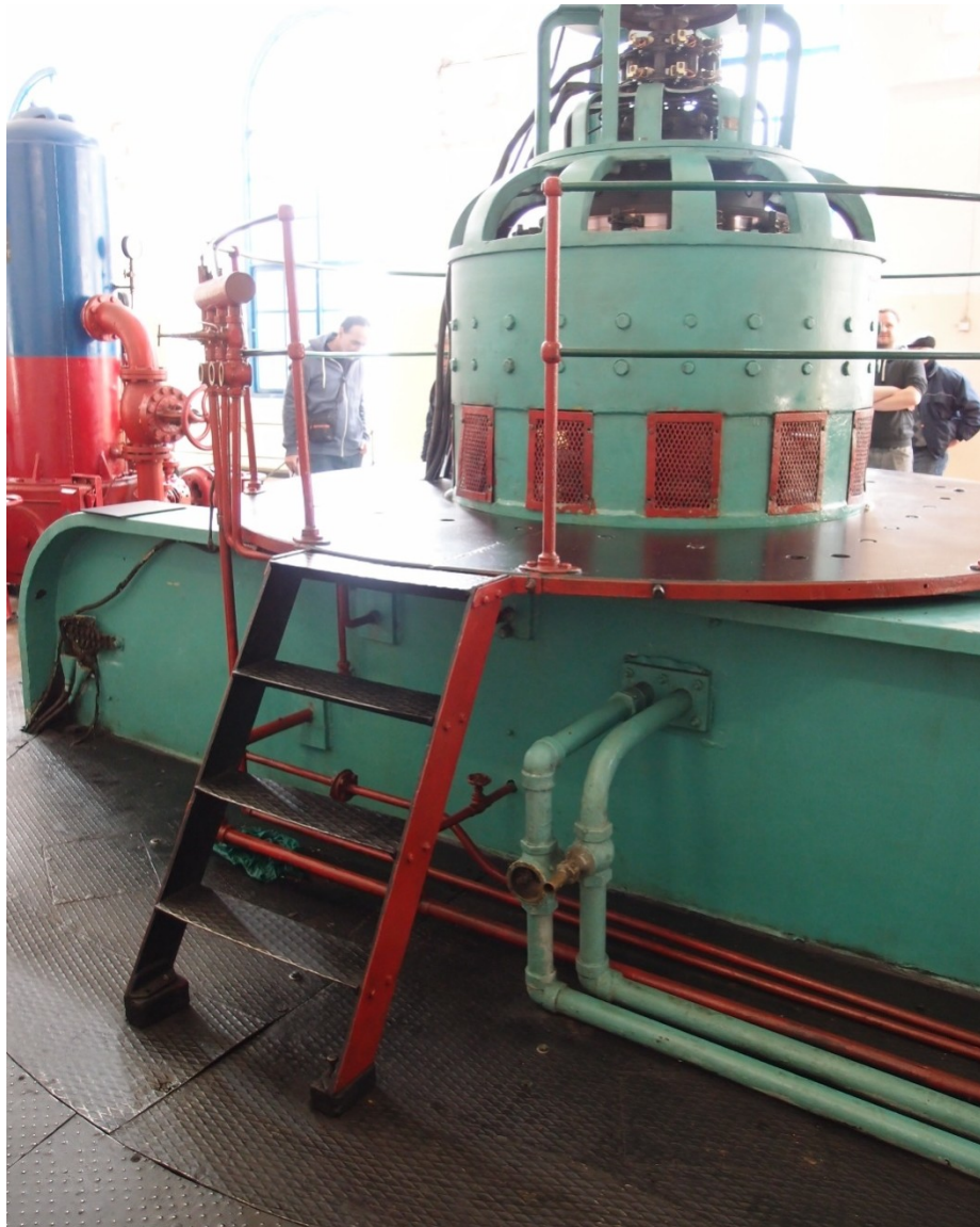
Obr. 2.7 Pohled na kryty a konstrukce
