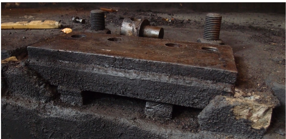
Obr. 2.3 Kotevní desky zabudované v základu
