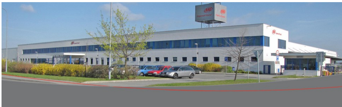
Obr. 2 Sídlo podniku Ingersoll-Rand CZ s.r.o. v Uničově [3]
