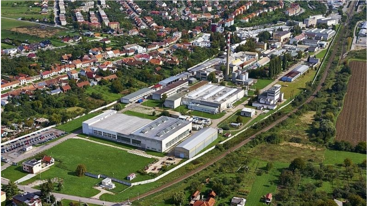
Obr. 1 areál společnosti Česká zbrojovka a.s. v Uherském Brodě [3]
