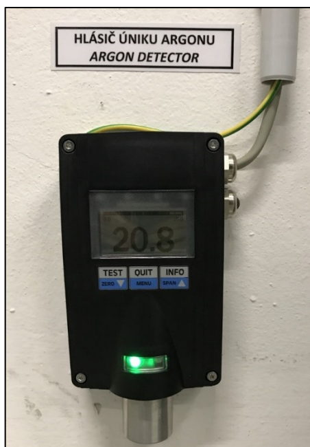
Obr. 16 – Detektor argonu v laboratoři aditivní výroby
