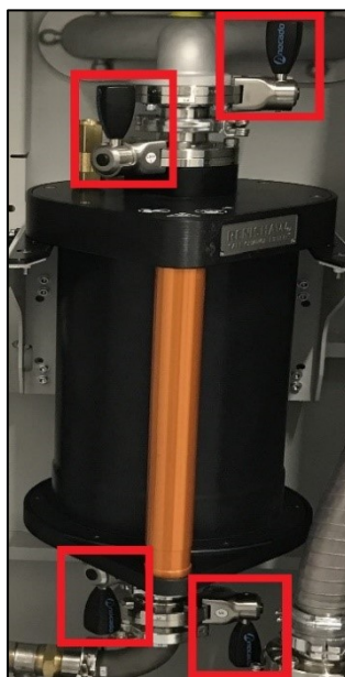
Obr. 19 – Oddělovací ventily na filtru
