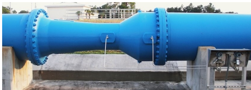
Obr. 14 Venturiho trubice s odběry tlaku v praxi [30]
