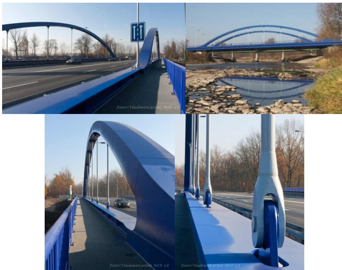
Obr. 9 Reálné fotografie konstrukce
