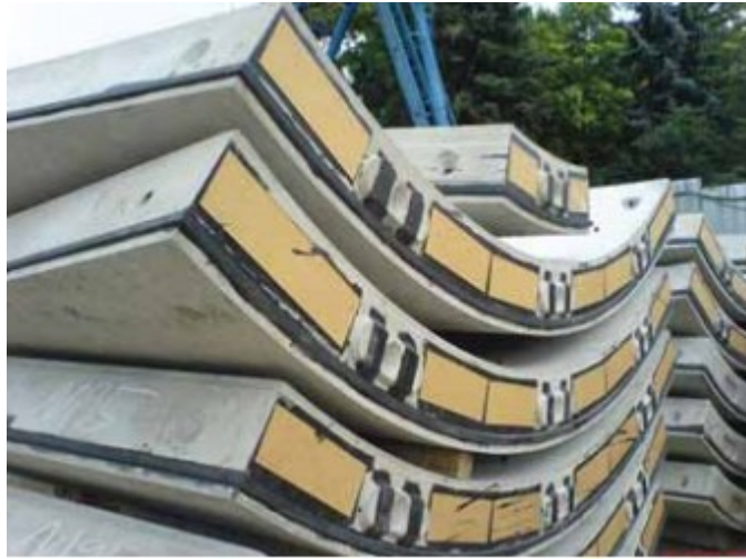
Obr. 10: Segmenty osazené izolací [12]
