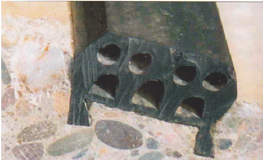
Obr. 12: Kotvené těsnění [5]
