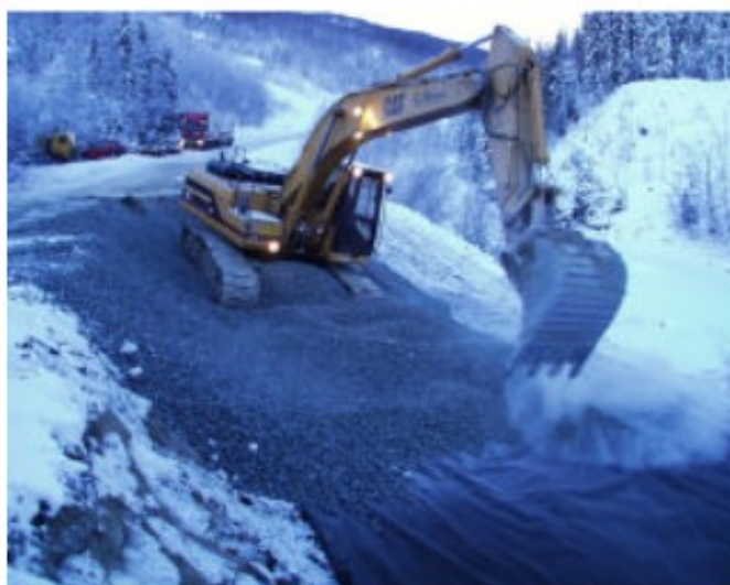
Obr. 28: Sanace silnice a sesuvu svahu [8]
