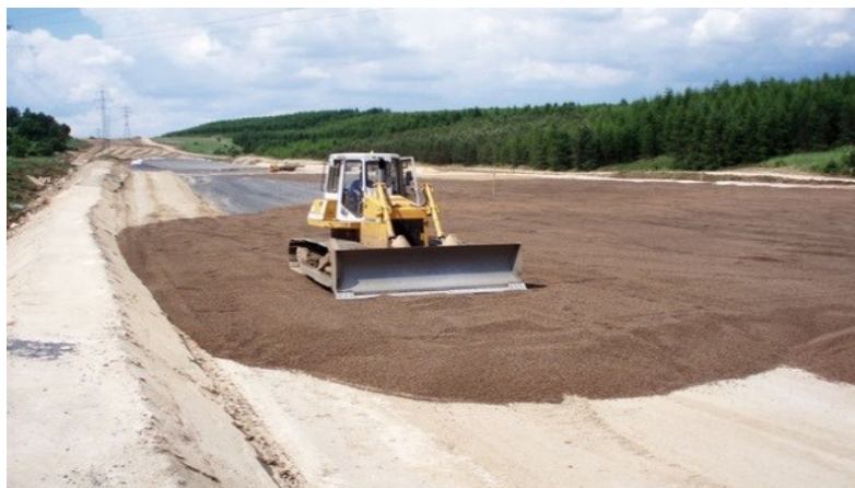
Obr. 10: Podkladní násyp na rychlostní komunikaci R6 [7]
