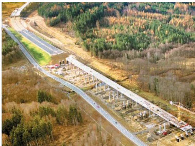
Obr. 27: Násyp u přechodové oblasti mostu [7]
