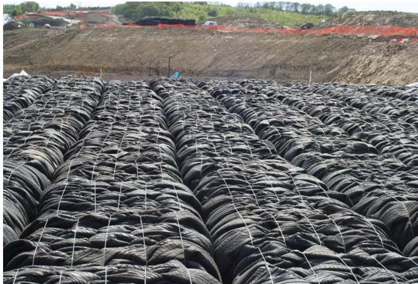
Obr. 31: Uložení balíků ze starých pneumatik, silnice A421 [16]
