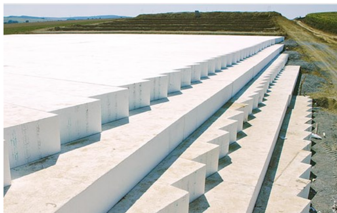
Obr. 24: Ukládání polystyrenu, dálnice D1 [6]
