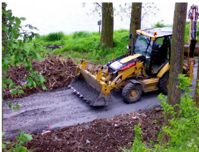
Obr. 22: Stavba cyklostezky Horní Počaply [12]
