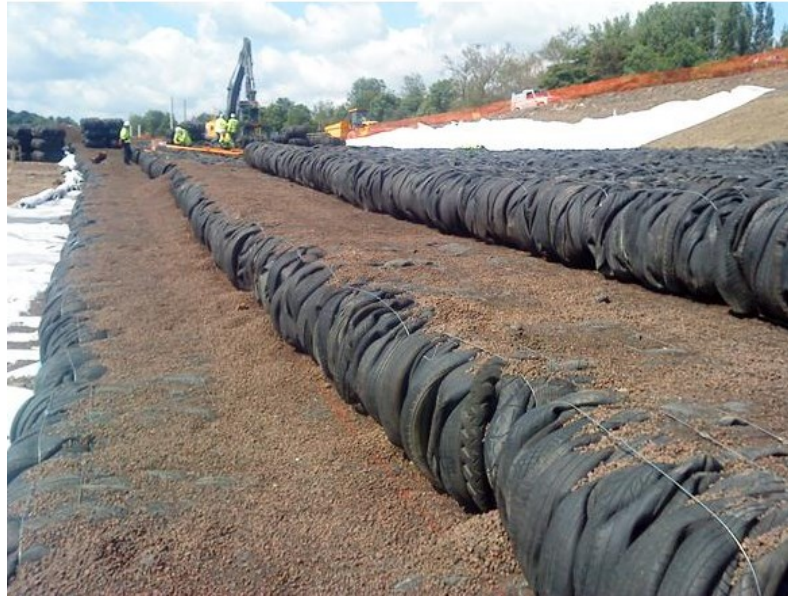
Obr. 30: Balíky z pneumatik prosypané keramickým kamenivem, silnice A421 [16]
