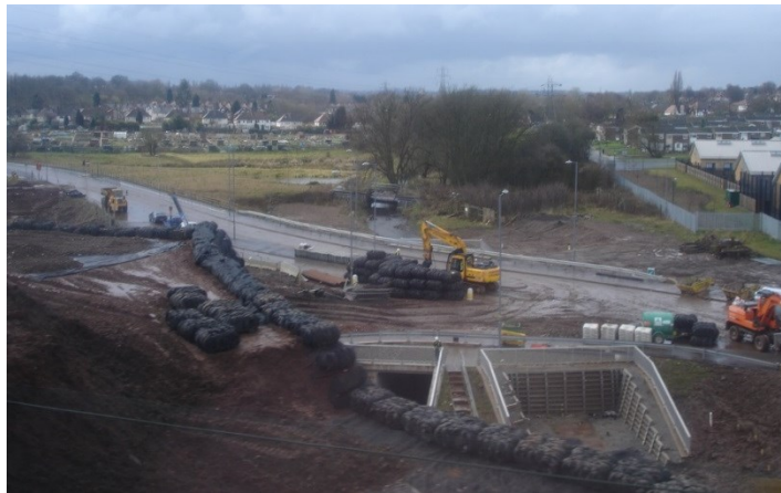
Obr. 17: Použití bloků starých pneumatik pro stabilizaci svahů po sesuvech [4]
