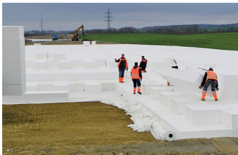
Obr. 35: Skládání polystyrenových bloku, [14]
