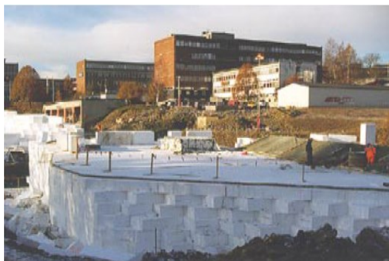
Obr. 25: Nábřeží se svislými stěnami z EPS bloků, Oslo (Norsko) [8]
