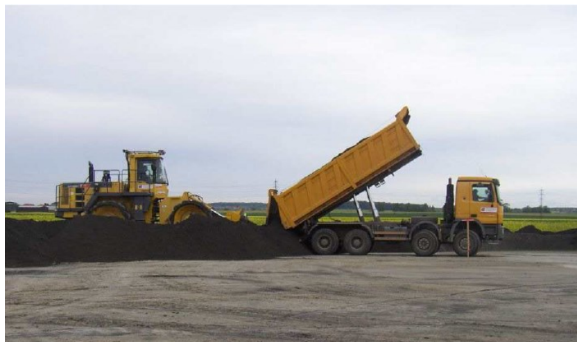
Obr. 33: Doprava popílku na staveniště budoucí dálnice D11 [17]
