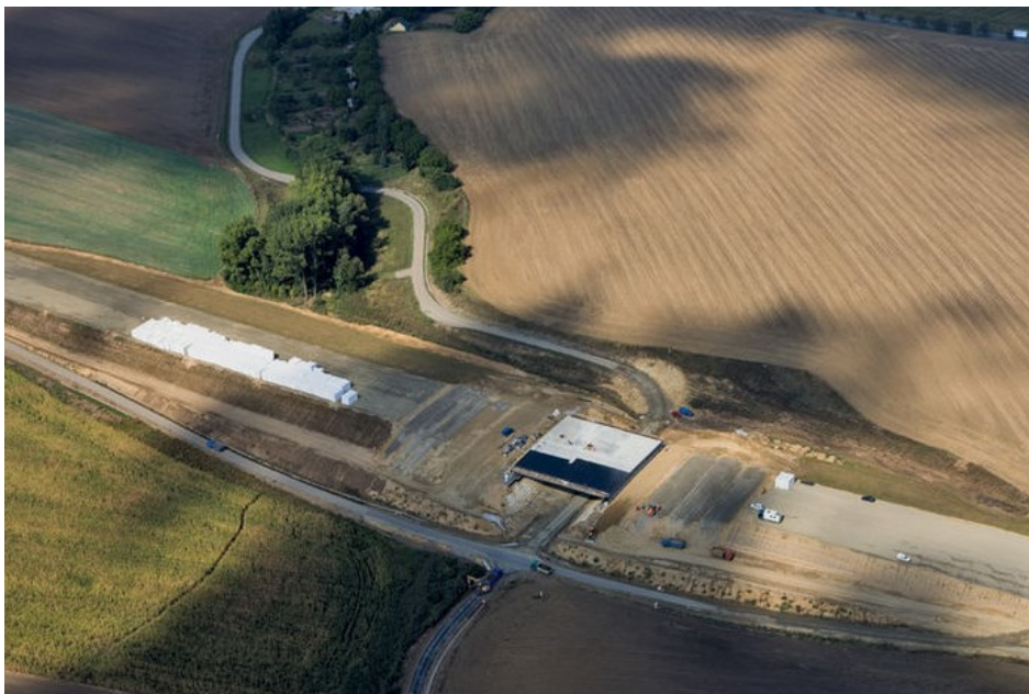
Obr. 36: Přechodová oblast mostu a násypu, [14]
