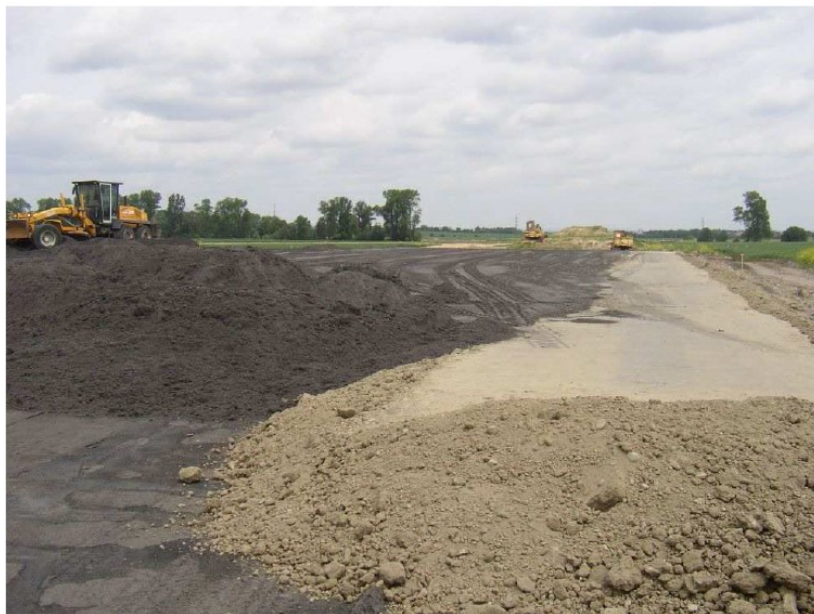
Obr. 32: Rozprostření popílku k hrázce [17]
