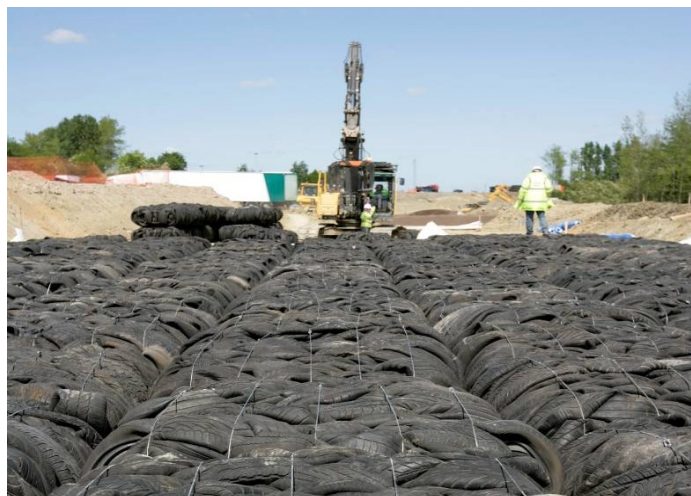
Obr. 18: Ukládání balíků starých pneumatik na silnici A421 [4]
