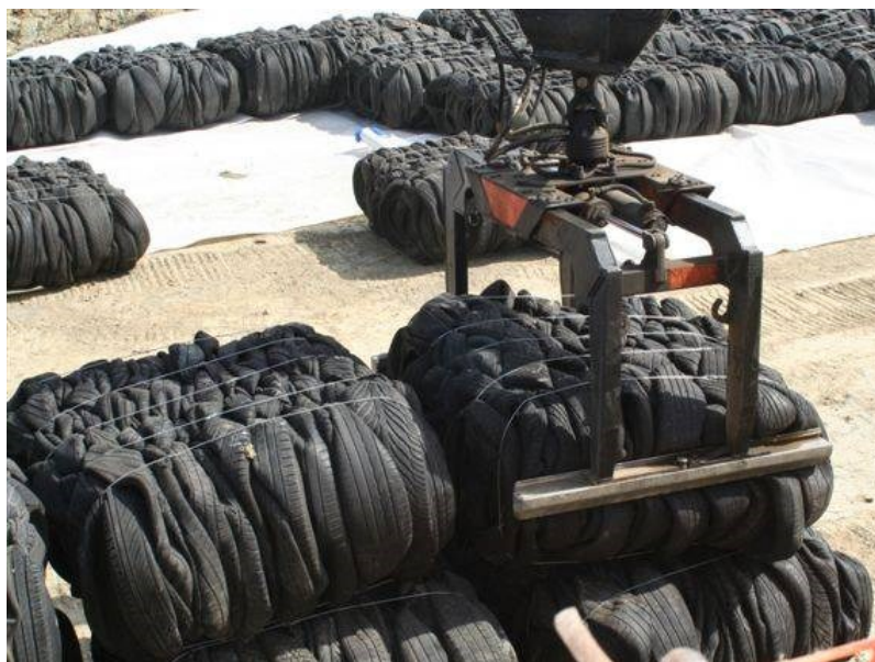
Obr. 16: Ukládání balíků starých pneumatik [4]
