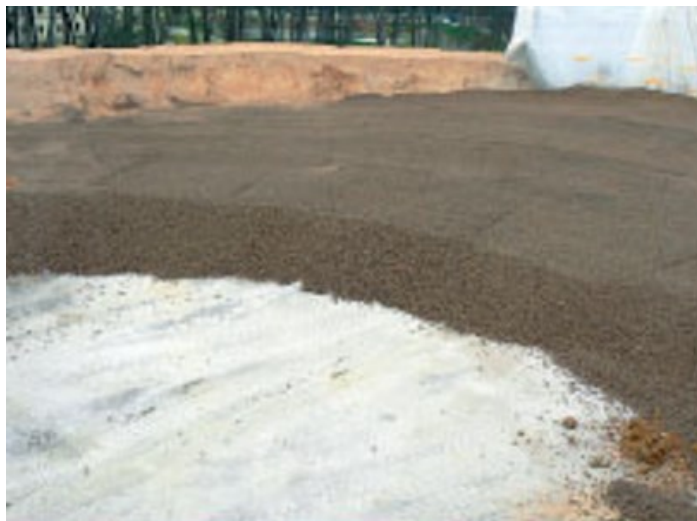
Obr. 21: Podkladní násyp na rychlostní komunikaci R6 [7]
