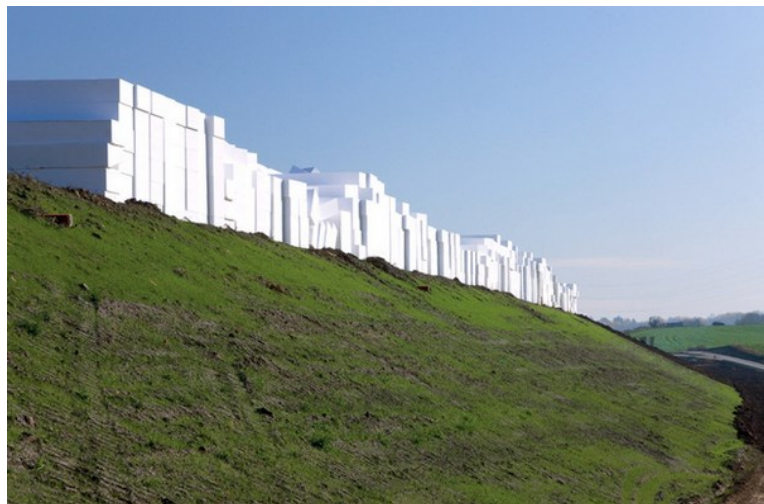
Obr. 34: Polystyrenové bloky, dálnice D1 [14]
