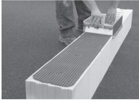
Obr. 3 Dávkovač lepidla s nastavitelnou tloušťkou vrstvy, zdroj: Příručka pro provádění SENDWIX, www.sendwix.cz
