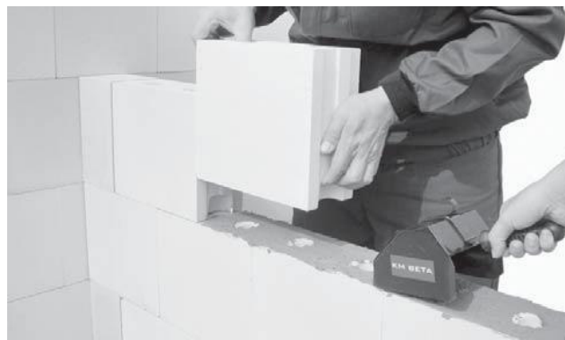
Obr. 4 Přesná lžíce pro nanášení lepidla, zdroj: Příručka pro provádění SENDWIX, www.sendwix.cz
