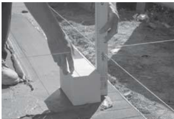
Obr. 1 Založení první cihly v rohu a srovnání pomocí vodováhy a napnutého provázku, zdroj: Příručka pro provádění SENDWIX, www.sendwix.cz
