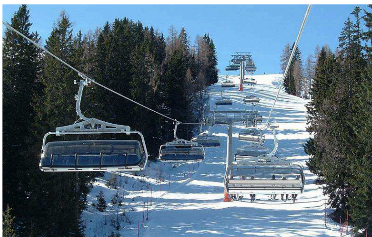
Obr. 5 Osobní visutá lanová dráha, 6-místná
