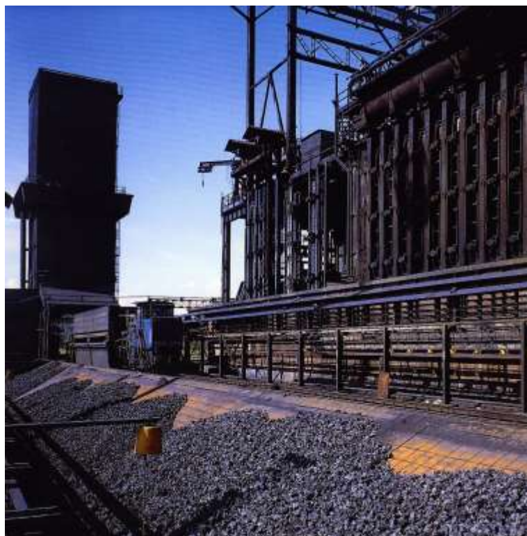
Obr. č. 1 – Velkokapacitní koksárenská baterie se sypaným provozem
