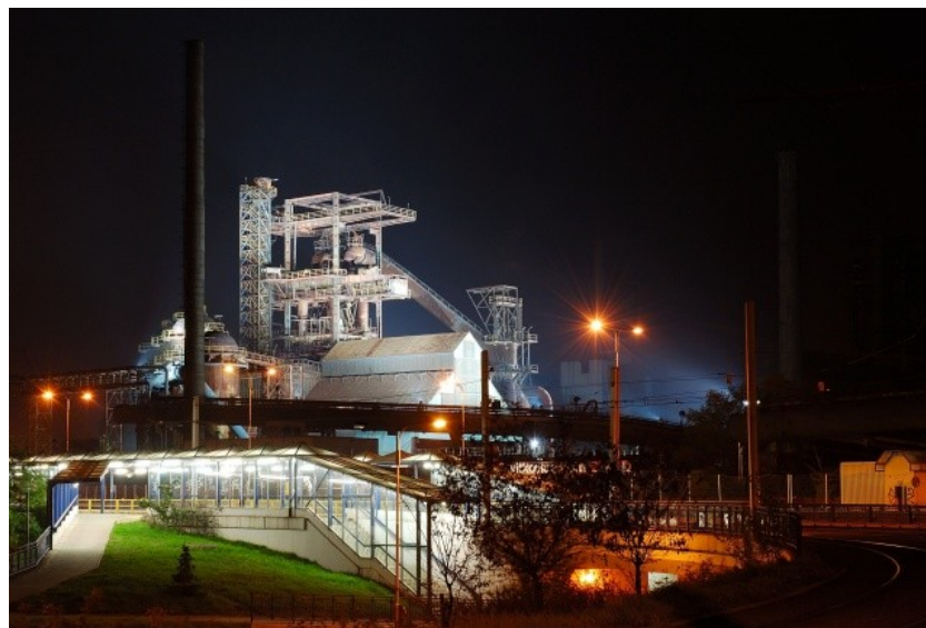
Obr. č. 10 – Dolní oblast Vítkovice [16]
