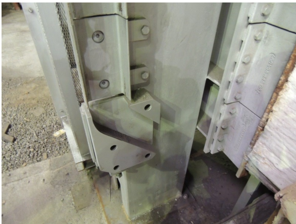
Obr. 5.4 Konstrukční uzpůsobení vodítek do oblouku [Vlastní foto]
