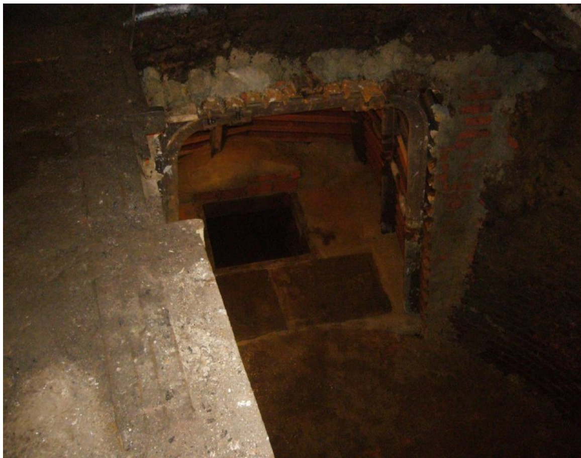
Obrázek 9: Vyražená a zapažená zátinka, obetonovaný vstup do staré chodby. Zdroj: archiv P. Šeda
