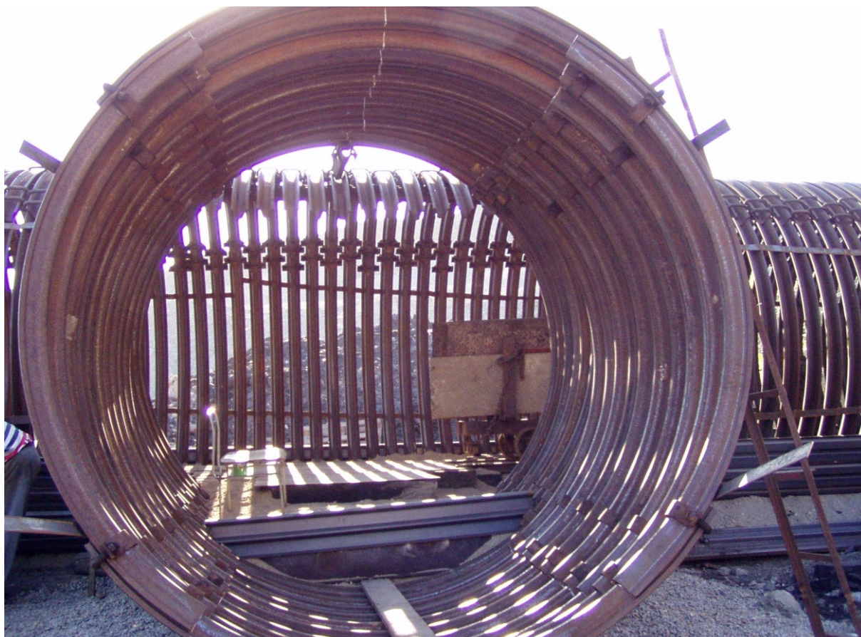
Obrázek 6: Budování celokruhové výztuže. Zdroj archiv P.Šeda
