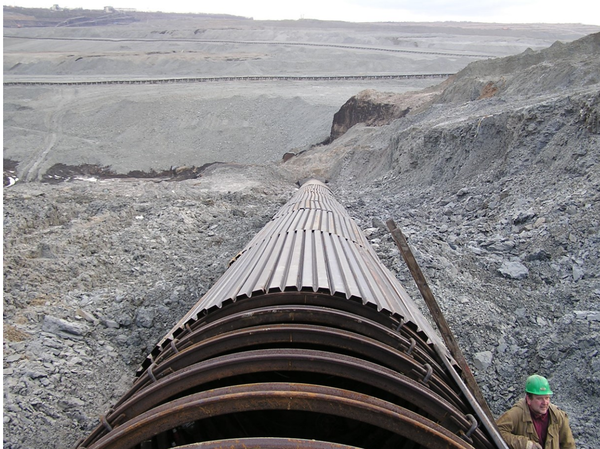
Obrázek 7: Pažení celokruhové výztuže. Zdroj: archiv P. Šeda
