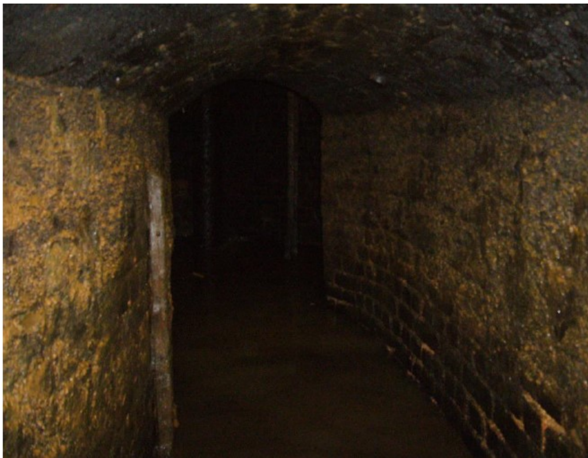
Obrázek 8: Stará nezdokumentovaná zděná chodba. Zdroj: archiv P. Šeda
