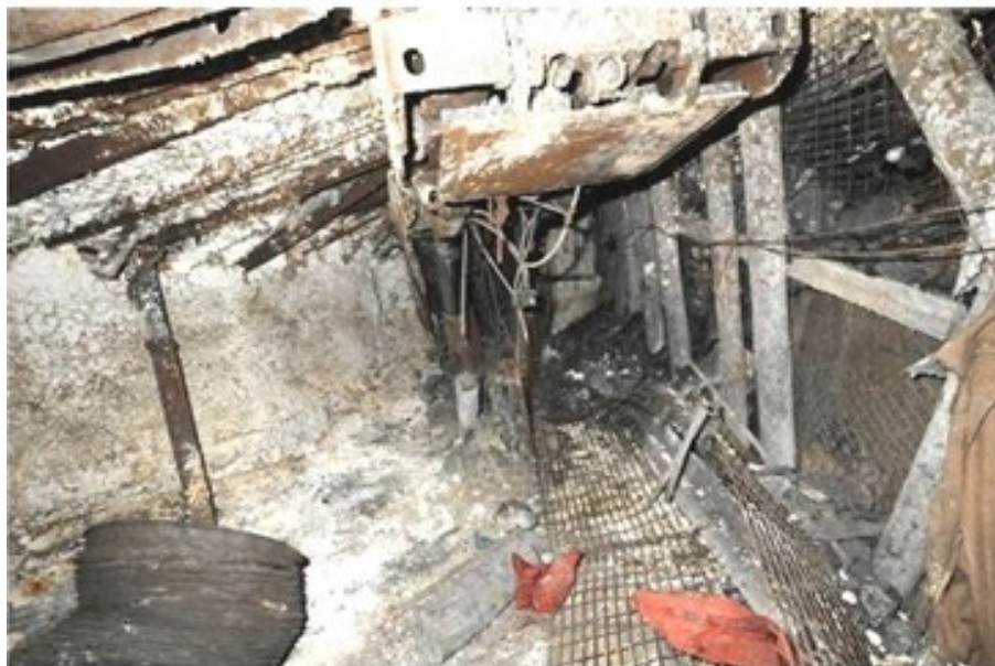
Obrázek č. 19: Dotěsněný prostor po vyplnění sekci (foto Zielinski).
