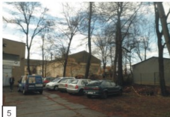
Pohled z Žižkovy ulice na SO05
