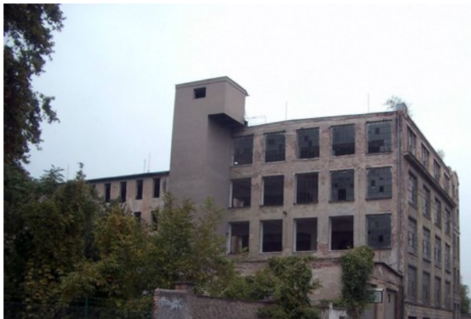
Obr. 3 Moravan před regenerací, zdroj: http://www.moravandevlop.cz/inzenyrske-sluzby.php
