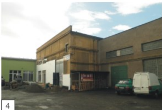
Pohled na severní část SO02, z Žižkovy ulice
