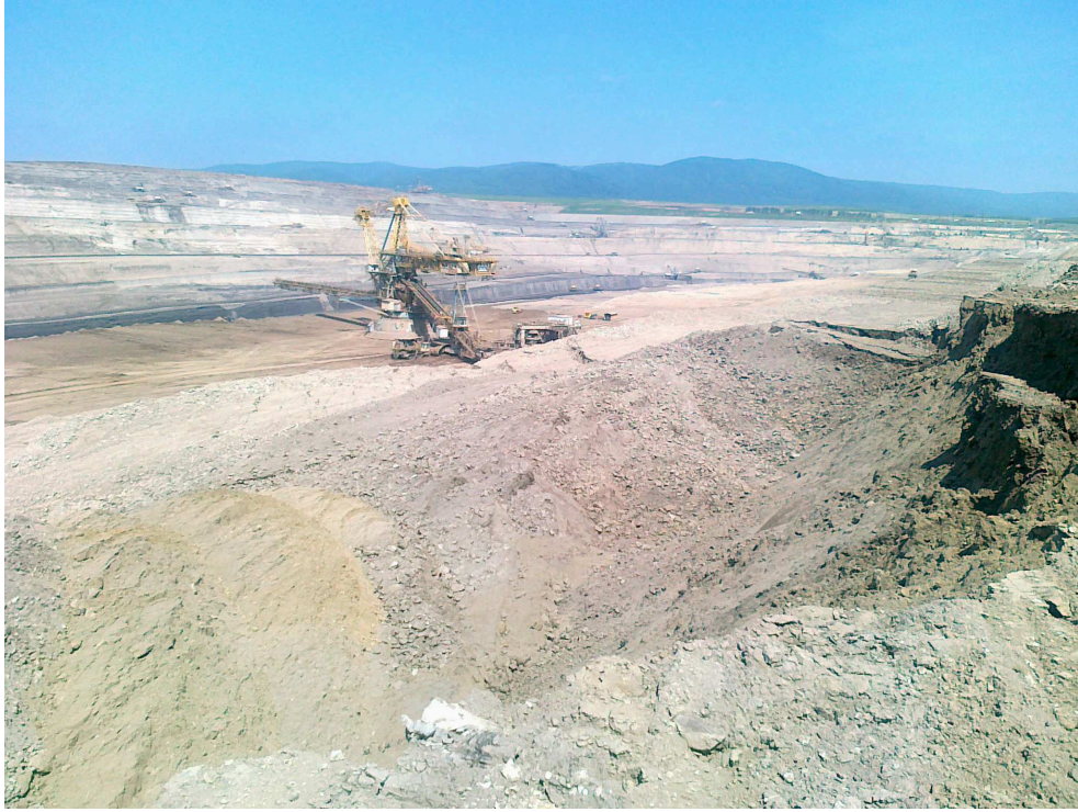
Obr. 7: Lokální sesuv etáže vnitřní výsypky dolu Bílina 2014 (Severočeské doly a.s.)
