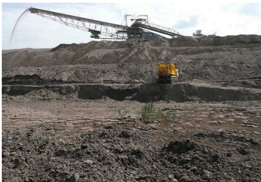
Obr. 8: Zakládání výsypky na odvodněné a vyuhlené dno lomu r. 2012 (Severočeské doly a.s.)
