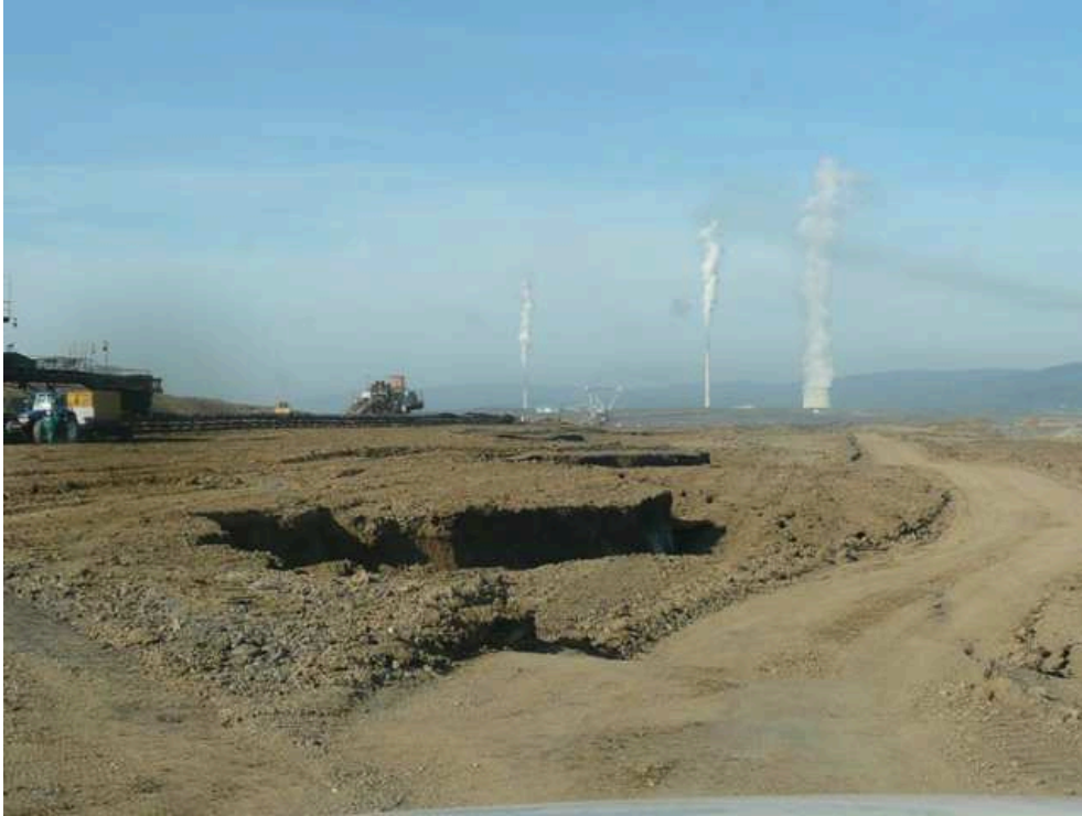
Obr. 5: Pohled na vnitřní výsypku lomu Libouš - pokles na výsypce v délce 1500 m činil až 3 m, r. 2012 (Severočeské doly a.s.)
