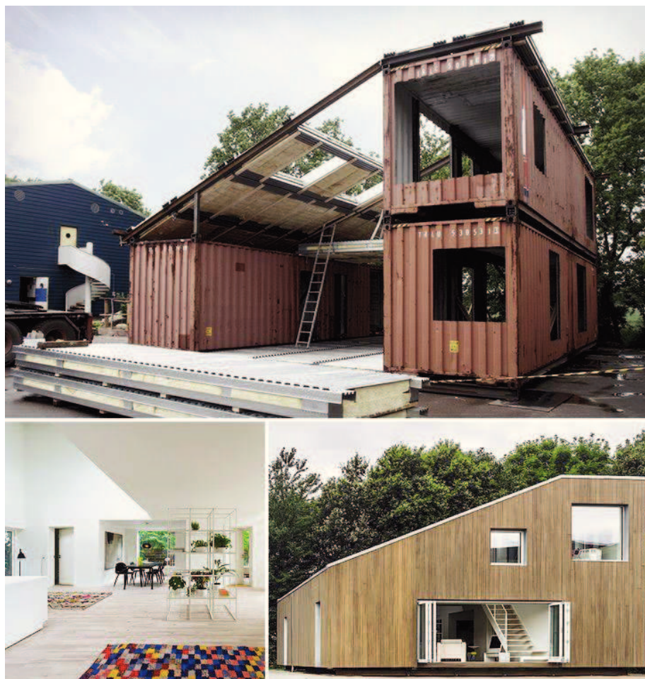
Obr. 3: Výstavba moderního RD v USA z lodních kontejnerů (zdroj:www.designboom.com)
