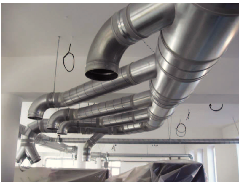
Obr. 35: Ukázka rozvodu SPIRO potrubí (zdroj: www.acword.cz )
