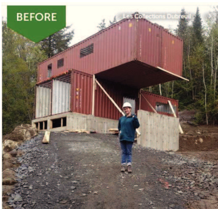
Obr. 1: Výstavba moderního RD v USA z lodních kontejnerů (před) (zdroj:www.designboom.com)
