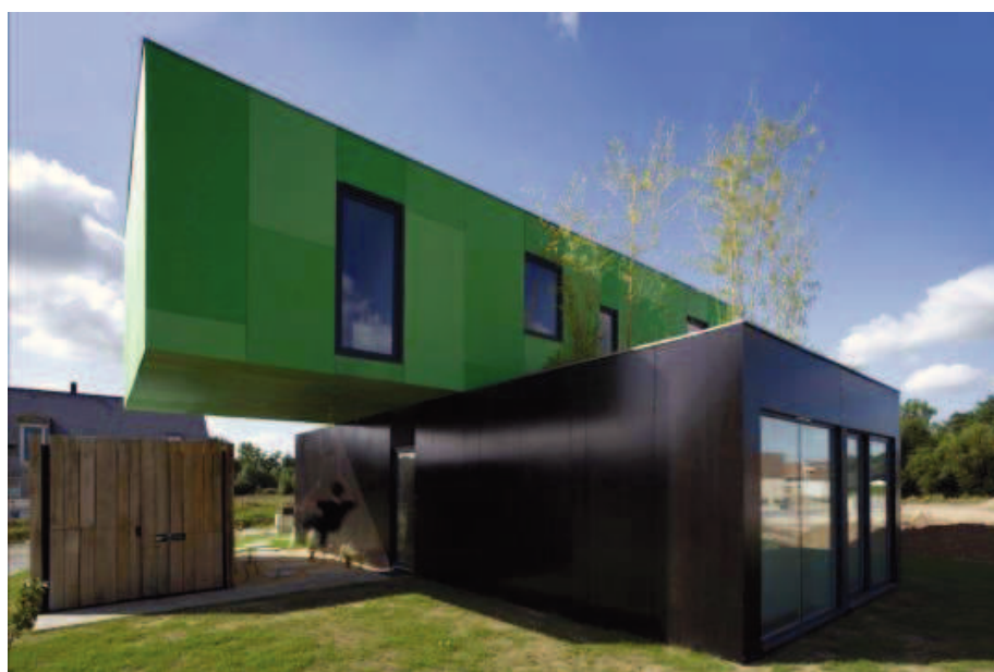
Obr. 4: Výstavba moderního RD v USA z lodních kontejnerů (zdroj:www.designboom.com)
