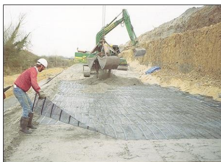
Obr. 1 - Pokládání geomříží
