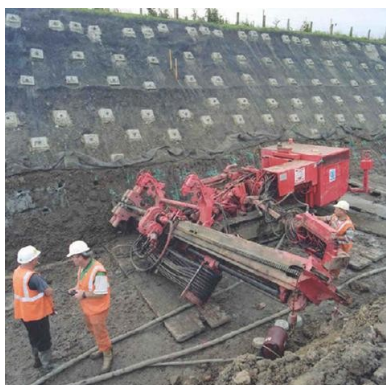
Obr. 2 - Instalace tuhých ocelových hřebíků
