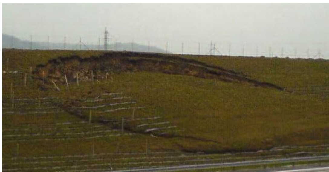
Obr. 20 - Sesuvu zářezu v zemině
