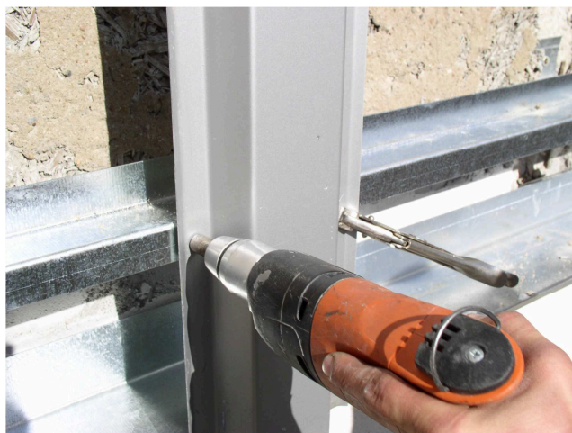
Obrázok č.10: Montáž OM profilov zvislého roštu [31]
