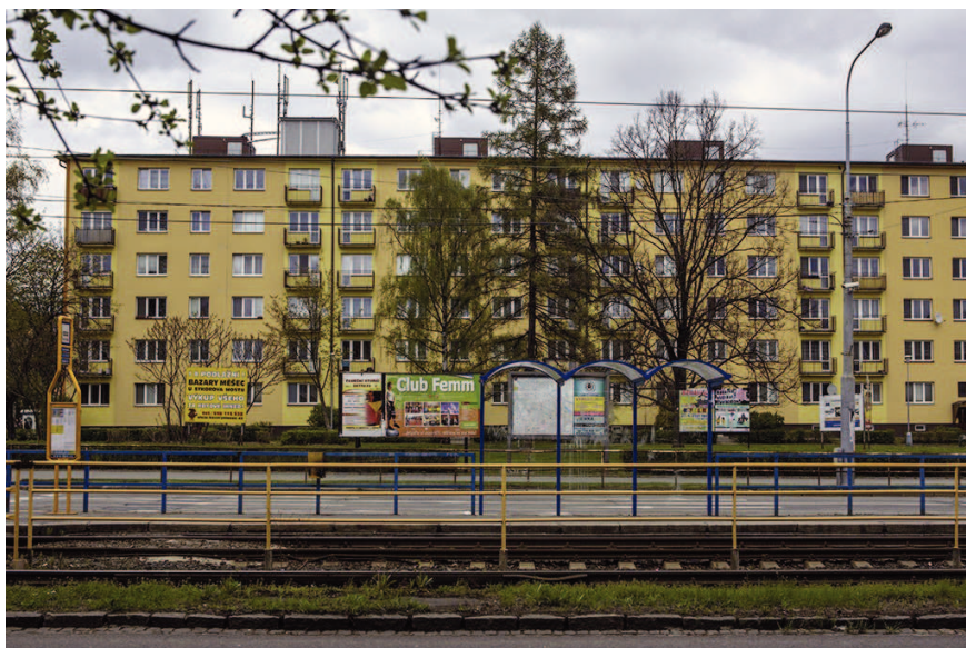
Obr. 5.23 Billboard Poruba vozovna (vlastní úprava)
