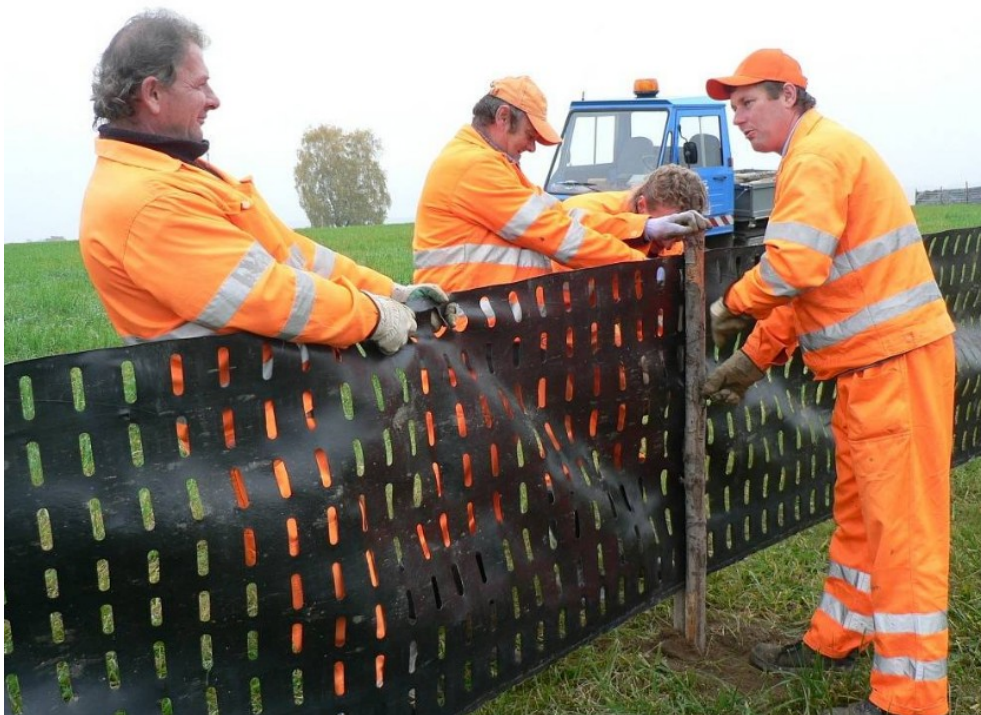
Obrázek č. 4 Instalace zásněžky 22
