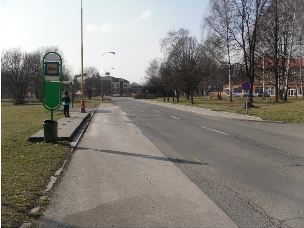
Úsek stávající ulice U Nádraží určený k odstranění
