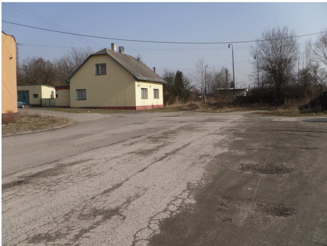
Rodinný dům na ulici U Závor určený k demolici
