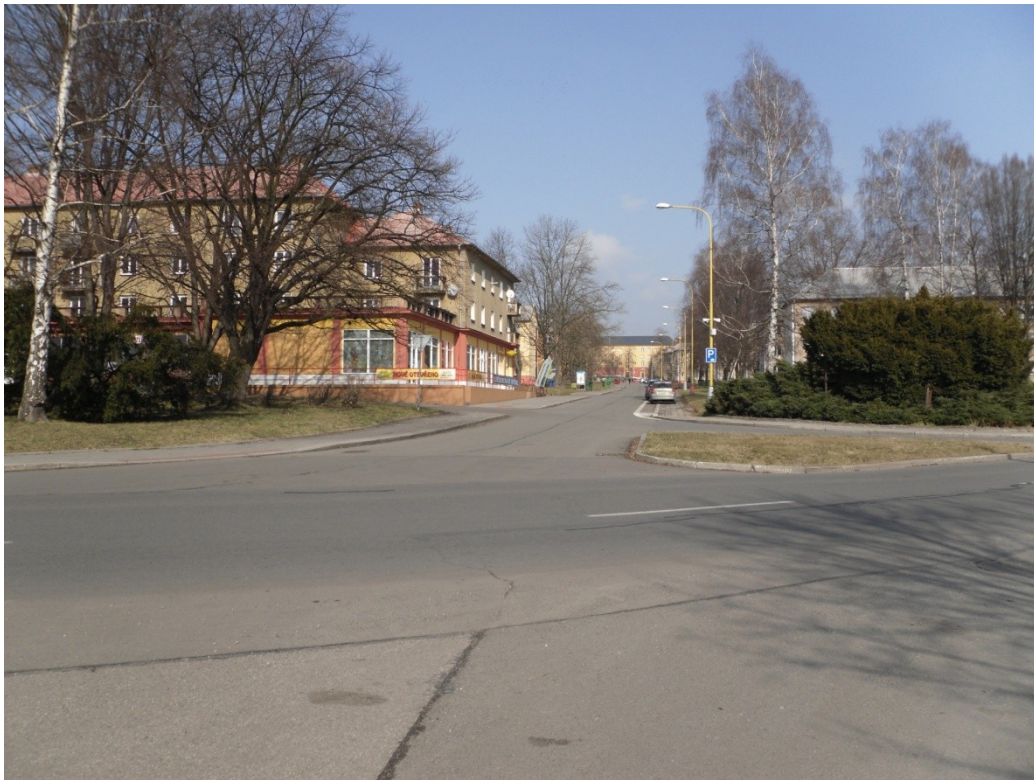
Křížení s ulicí Dukelskou, odkud bude stávající ulice U Nádraží prodloužena na navrhovaný úsek trasy
