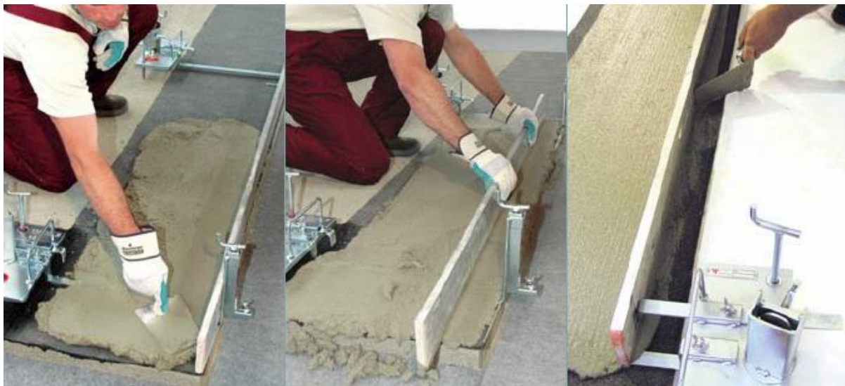
Obr. 4 Nanášení, vyrovnávání a odstraňování malty [2]
