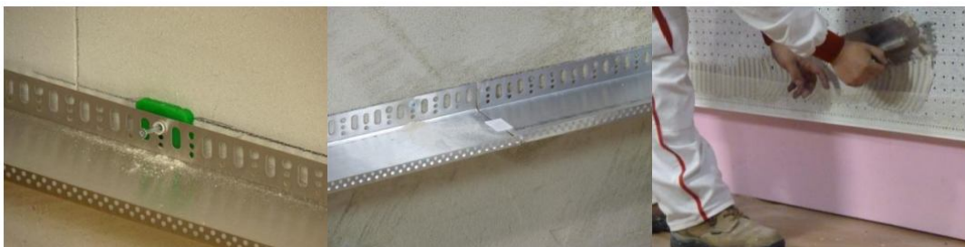
Obr. 17 Distanční podložka, spojka a okapnička soklového profilu [4]
