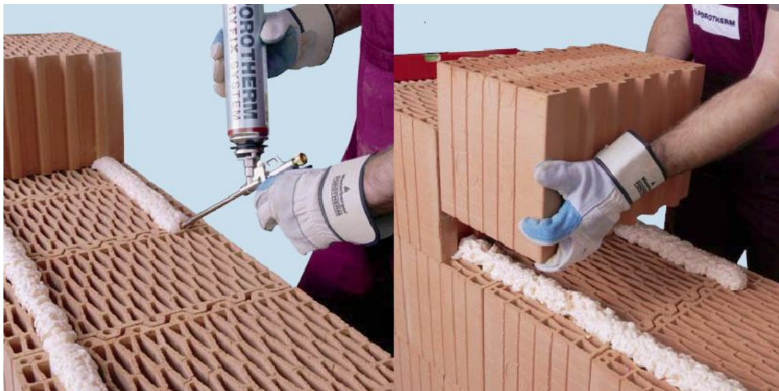
Obr. 16 Nanášení pěny a ukládání cihelných bloků [3]
