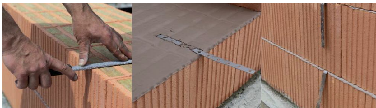
Obr. 11 Přebroušení cihly v místě spony, vložení spony a její následné ohnutí [1]
