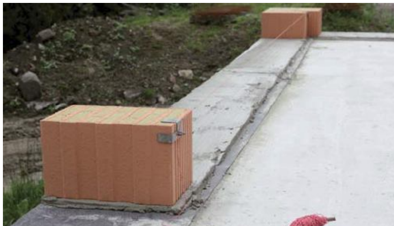
Obr. 5 Osazení rohových cihel a napnutí vodící šňůry [1]
