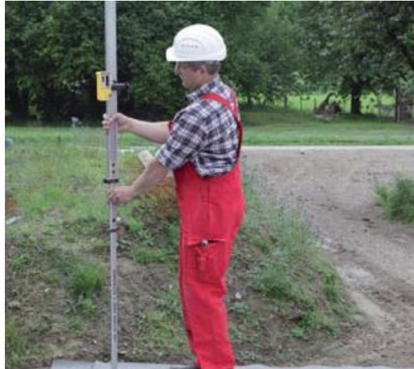
Obr. 2 Výškové zaměření podkladní plochy [1]
