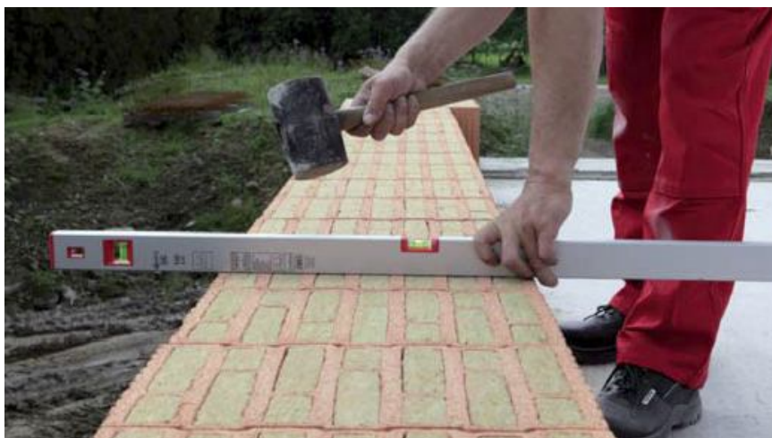
Obr. 9 Urovnání cihel pomocí vodováhy a gumového kladívka [1]
