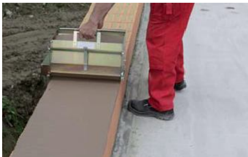
Obr. 6 Nanášení malty maltovacím vozíkem [1]
