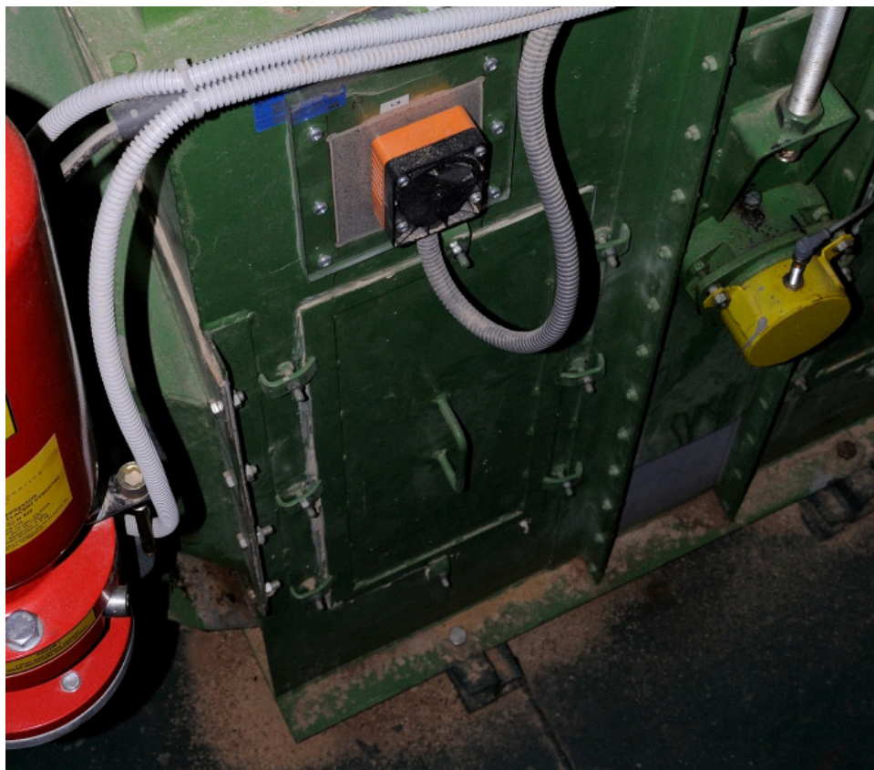
Obrázek 12: Pata sladového elevátoru
