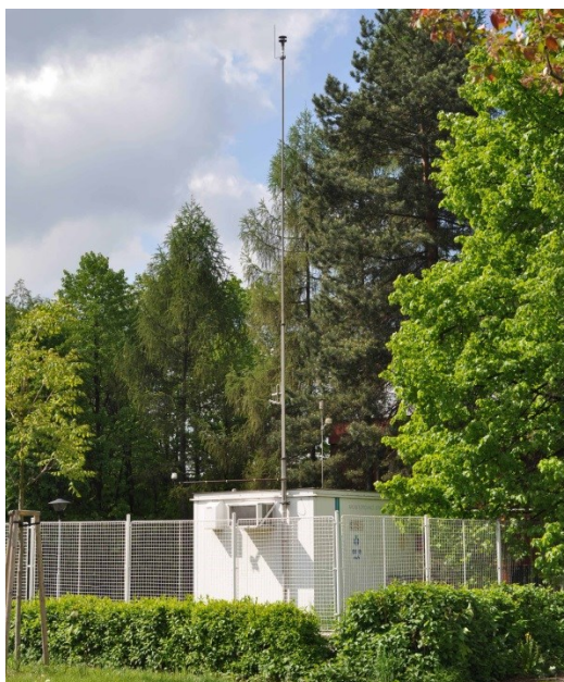
Obrázek 5.2: Automatizovaná meteorologická stanice v Orlové (vlastní foto)
