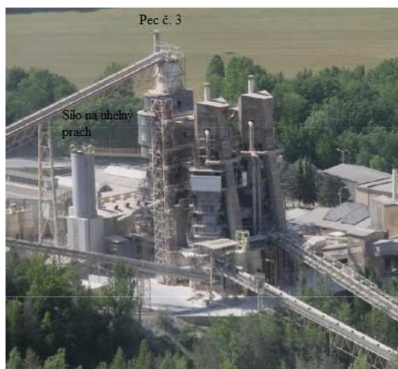
Obr. č. 6 – Pec č. 3 a silo na uhelný prach [16]
