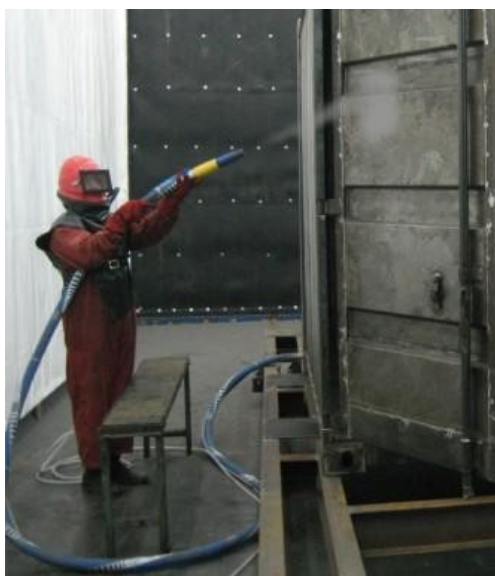
Obr. 2 – Způsob ručního tryskání [9]
