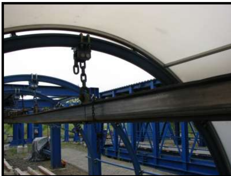
Obr. 4.4 - Řetěz přehozený přes závěsnou dráhu
