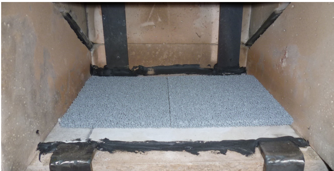
Obr. 13.4 Pěnokeramická vrstva ve spalovací komoře před zkouškou
