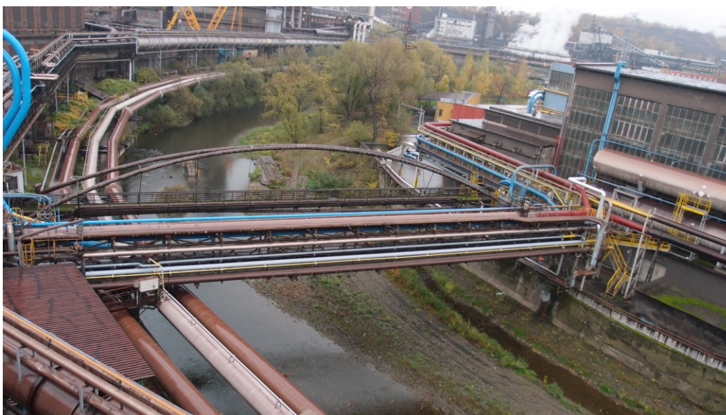
Obr. 1 Potrubní most přes řeku Olši.
