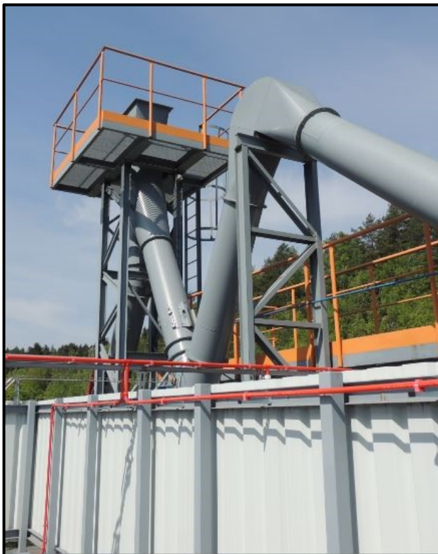
obr. 2.10 – protiexplozní komín na střeše FLS boxu
