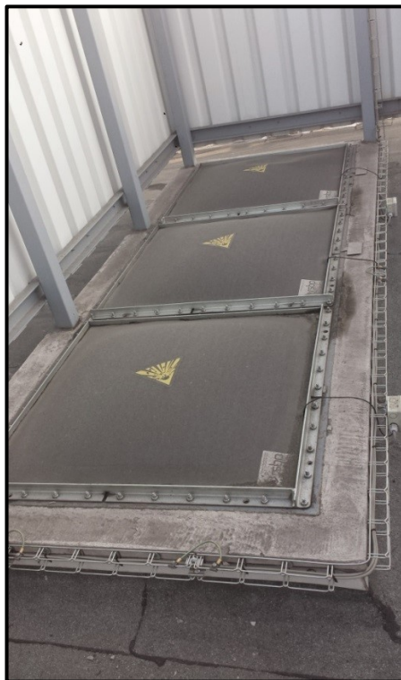
obr. 2.8 – odlehčovací membrány umístěny na střeše FLS boxu
