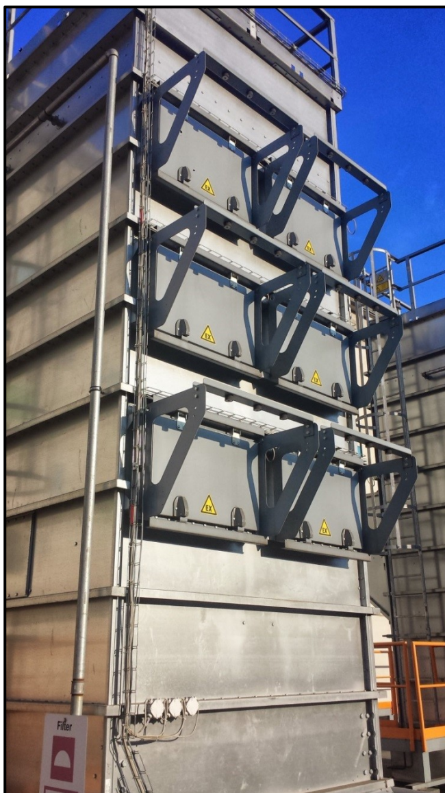
obr. 2.6 – filtr SCHEUCH, pohled na odlehčující membrány BRILEX
