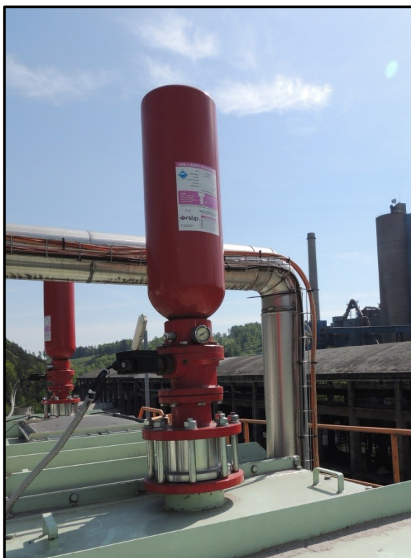
obr. 2.9 – HRD bariéra namontována na zavážecím redleru
