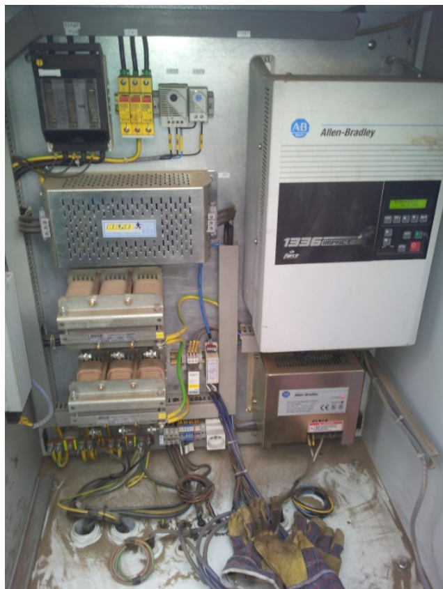
Obr. 5 - 5 Příklad uspořádání FM ve venkovním rozvaděči
