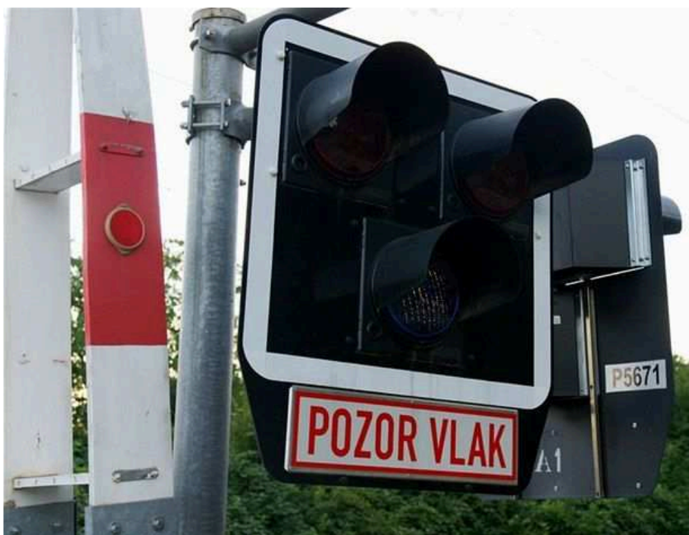
OBRÁZEK 3: VÝSTRAŽNÍK 97-PV
