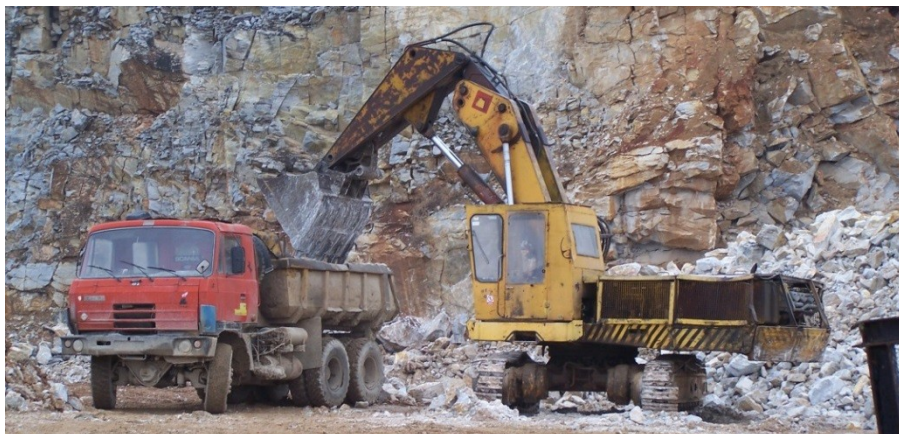
Obrázek č. 1 : nakládka vápence [foto autor]
