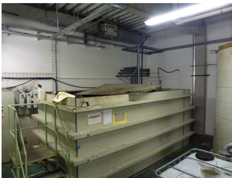
Obrázek 4: Akumulační nádrž na shromažďování odpadu ve firmě Aisan Industry Czech s.r.o. Autor: Mašek Pavel
