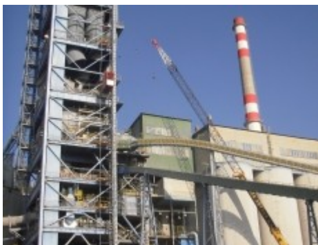
Obr. 4.1.5. Zákazník Lafarge Cement, a.s.
