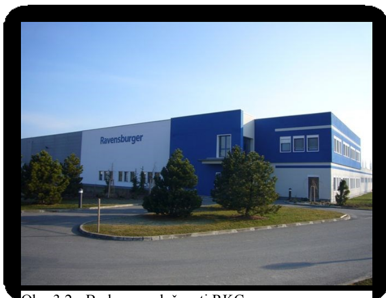
Obr. 3.2 - Budova společnosti RKC
