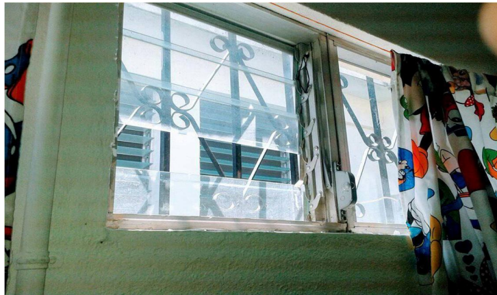
Foto No. 6: colocación de vidrios en forma de paleta en la clínica dental.
