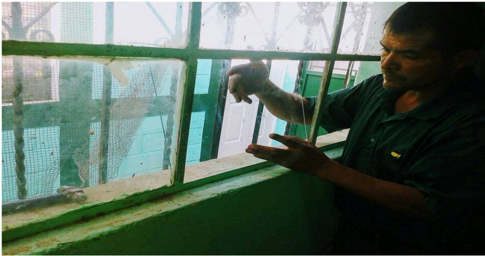
Foto No.12: colocación de vidrios en la escuela Isidoro Zarco Alfasa.
