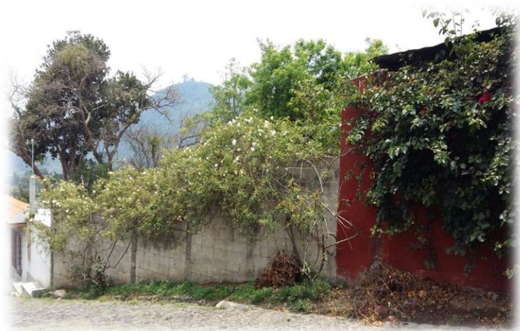
Figura 10. Pared exterior trasera
