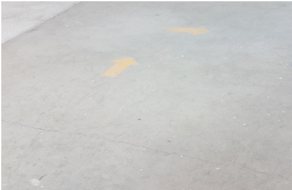
Figura 15. Piso fundido de cemento
