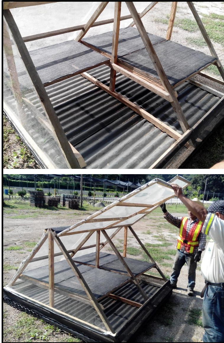
Figura 21. Estructura de madera y puertas del deshidratador
