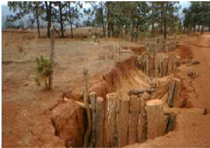
Figura 75. Fotografía de barreras de conservación del suelo.
